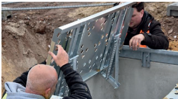
Slipp dørene forsiktig på plass og test utløsermekanismen.
