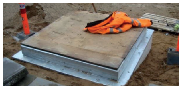
Dekk til åpning med en kraftig finérplate.
